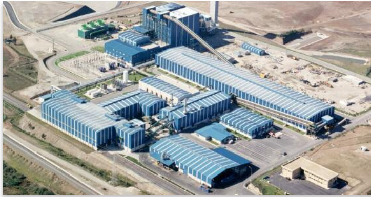
Complexo industrial de Sogama en Cerceda (A Coruña)
